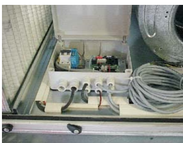
Abb. II/4: Klemmenkasten
