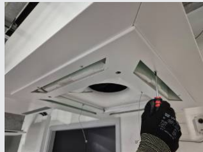
6. Blende befestigt an Sicherungsseilen.
