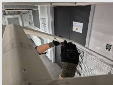
8. Filter einsetzen und sichern.
