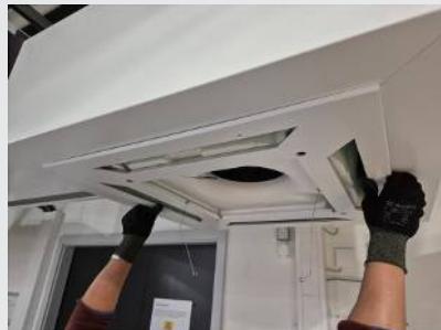
5. Sicherungsseile montieren.
