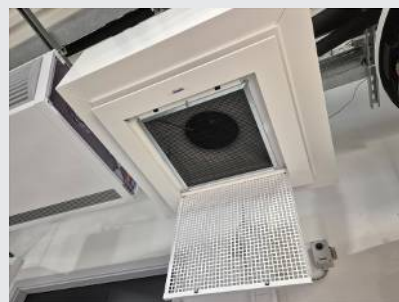
12. Blende korrekt montiert.
