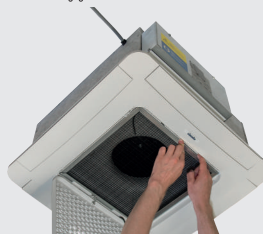
4. Filter entnehmen, reinigen und wieder einsetzen. Bei erhöhtem Verschmutzungsgrad den Filter wechseln.
