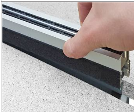
Abb. 11: Schlitzauslass einschieben
