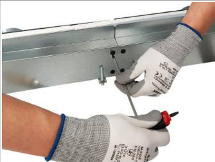
Abb. 7: Anschlusskästen miteinander verschrauben
