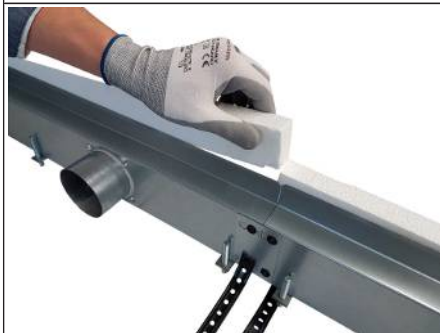
Abb. 9: Montageschutzabdeckung entfernen.
