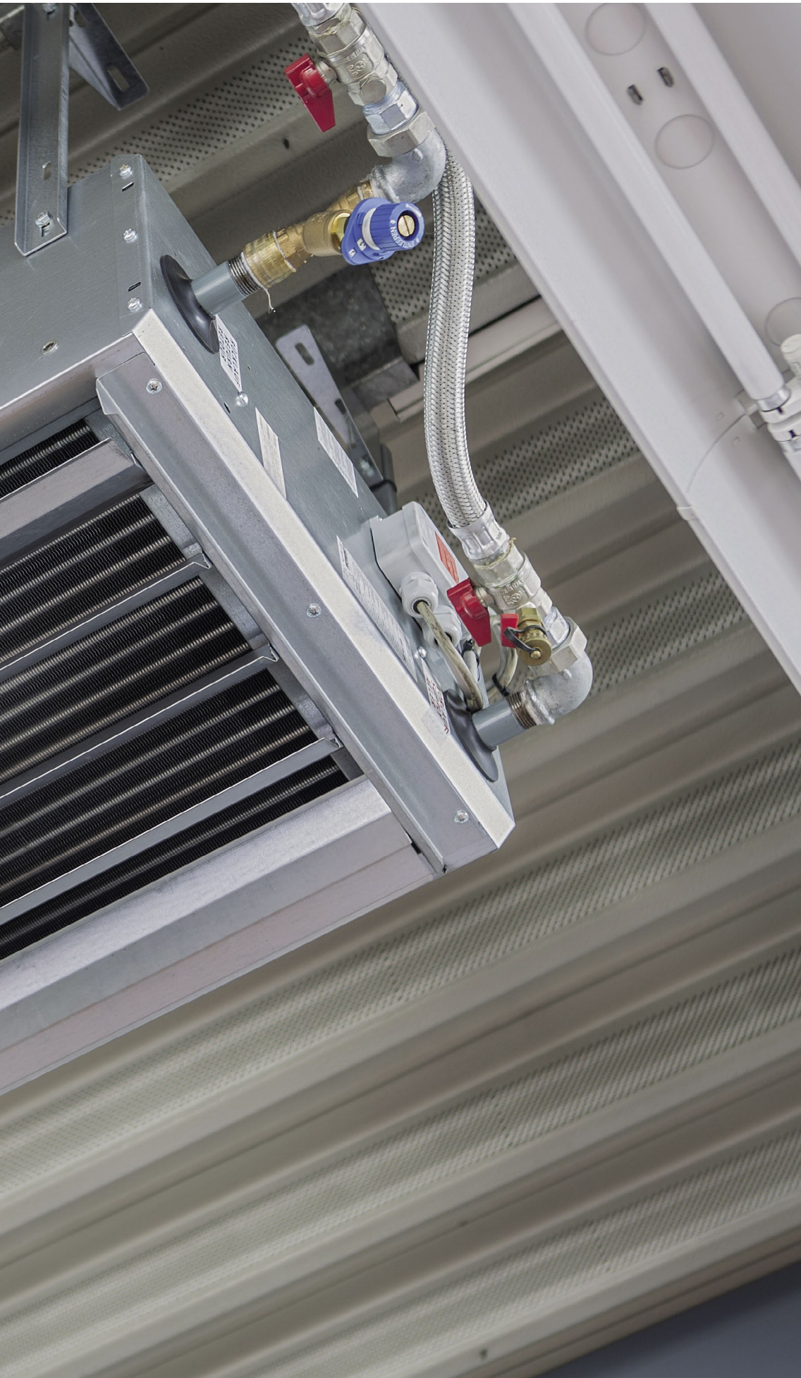
An den Decken montierte TIP Luftheritzer beheizen die Ausstellungshalle des Autohauses Seyfarth in Gotha.
