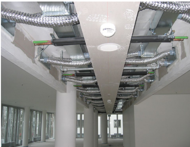
Abb. 13. Beispielhafte Montage des KSW an das gebäudeseitige Luftführungssystem
