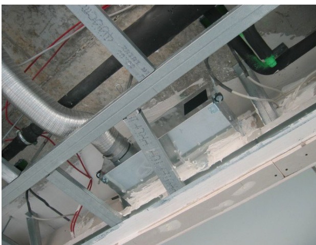
Abb. 14. Beispielhafte Montage des KS an das gebäudeseitige Luftführungssystem
