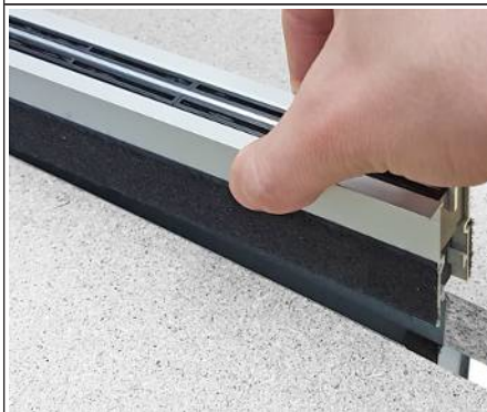
Abb. 11: Schlitzauslass einschieben
