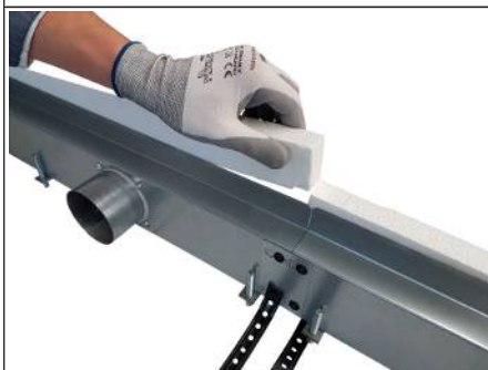
Abb. 9: Montageschutzabdeckung entfernen.
