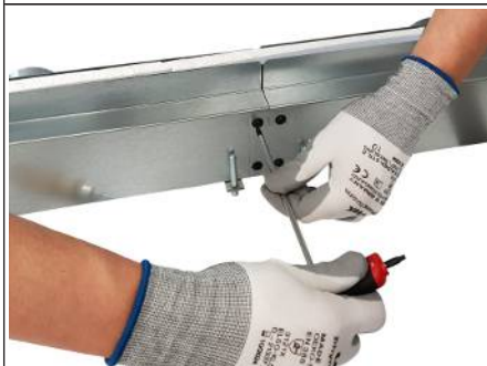
Abb. 7: Anschlusskästen miteinander verschrauben
