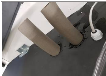
Abb. 10: Verrohrung bauseitig isolieren
