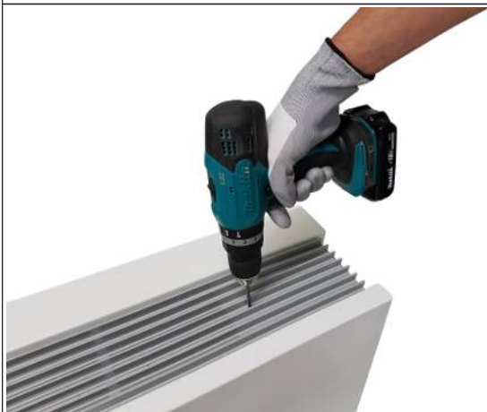
Abb. 10: Luftaustrittsgitter verschrauben.
