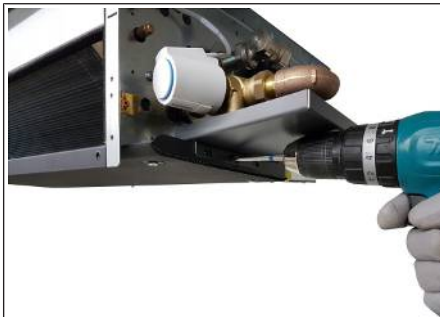
Abb. 73: Ventilkondensatwanne (Deckenausführung) demontieren
